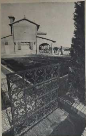
Particolare del Club-House
